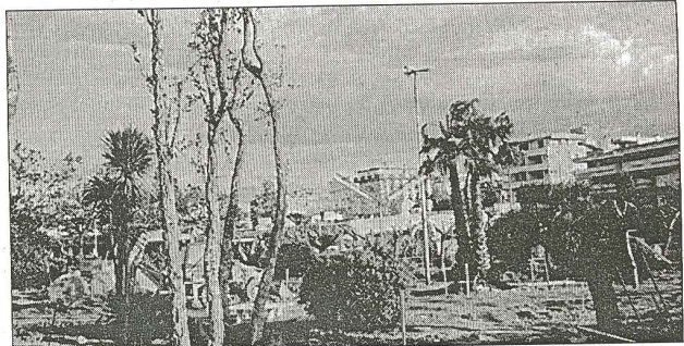
I lavori di ristrutturazione del minigolf sono cominciati 20 giorni fa
